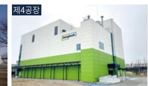
천연물 추출 전용 공장 준공
